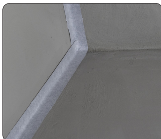
1. Tåtremsa FB 182 appliceras i övergång golv/vägg och vägg/väggvinkel.
