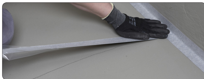
2. Ev. gjutskarvar förseglas också med FB 182.
