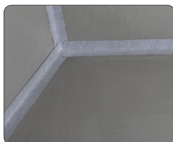
1. Tåtremsa FB 182 appliceras i övergång golv/vägg och vägg/väggvinkel.
